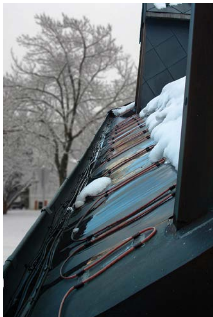
Instalacja na połaciach dachów pochylonych przylegających do rynien
