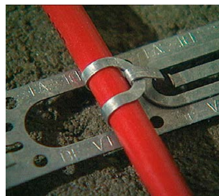
Kabel grzejny przymocowany do taśmy DEVIfast™
