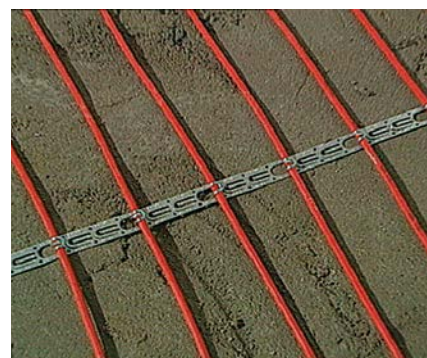
Kabel grzejny przymocowany do taśmy DEVIfast™
